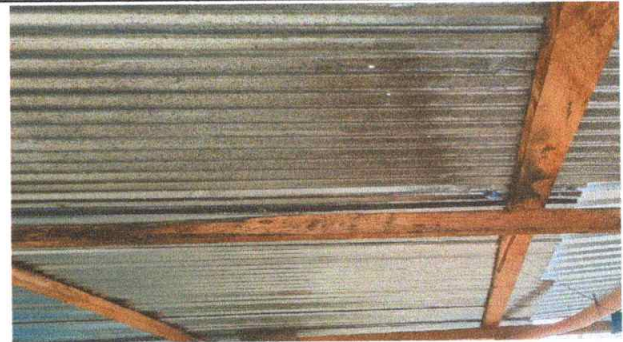
Foto 4: Sustitución de estructura de soporte de madera, por tubos rectangulares galvanizados 4x2, 1.50 MM.
