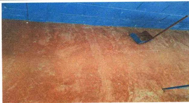
Foto 3: Sustitución de piso de torta de cemento liquido por piso de granito.
