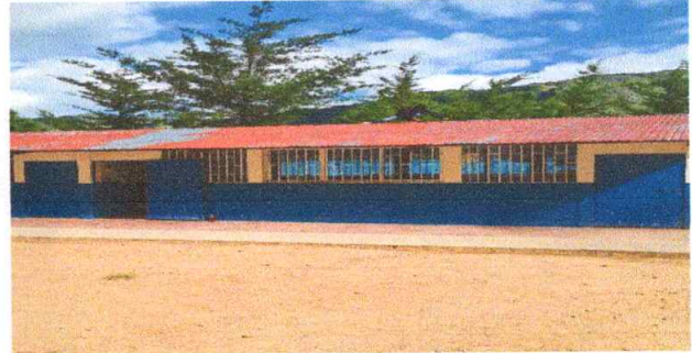
Foto 2: Sustitución de capote de lámina para lámina troquelada dentado multiferfiles.
