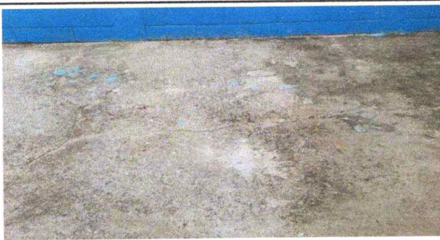
Foto 5: Sustitución de piso de torta de concreto de 10 cm de espesor.
